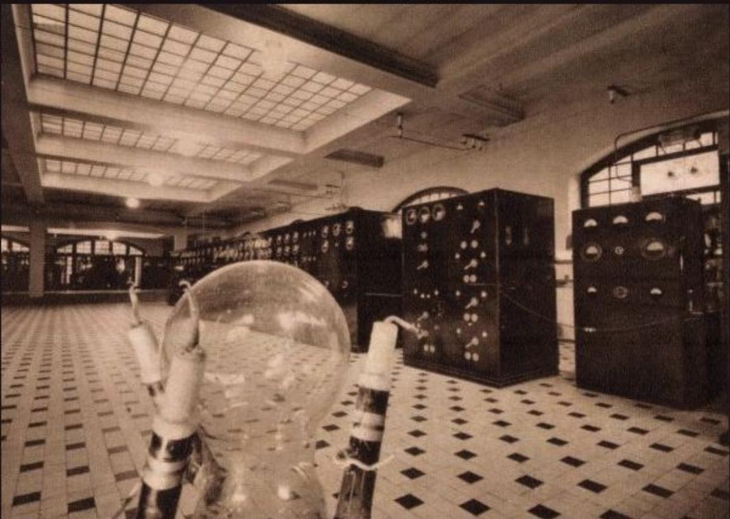
L'impressionnante salle technique abrite les émetteurs proprement dits (ondes moyennes et courtes). Ces installations sont constamment modernisées et renforcées selon les toutes dernières données du progrès dans le domaine de la radiotechnique.
